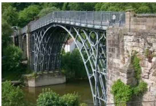
Figura 1.1 - Ponte de Coalbrookdale
