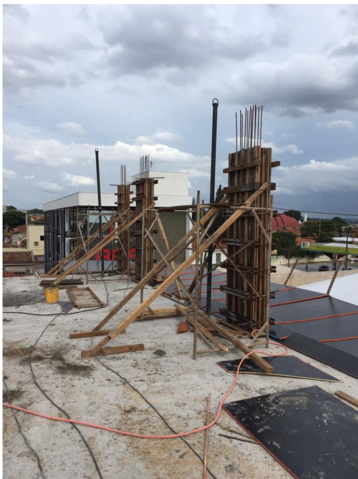
Figura 03: pilares ainda nas formas
