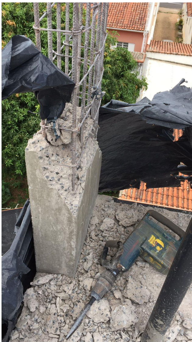
Figura 04: pilar fora do prumo sendo demolido
