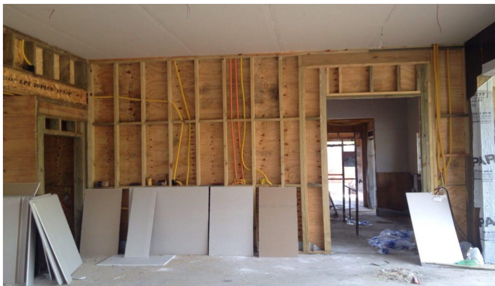
FIGURA 03: PAREDE PRONTA PARA O FECHAMENTO COM PLACAS EM GESSO
