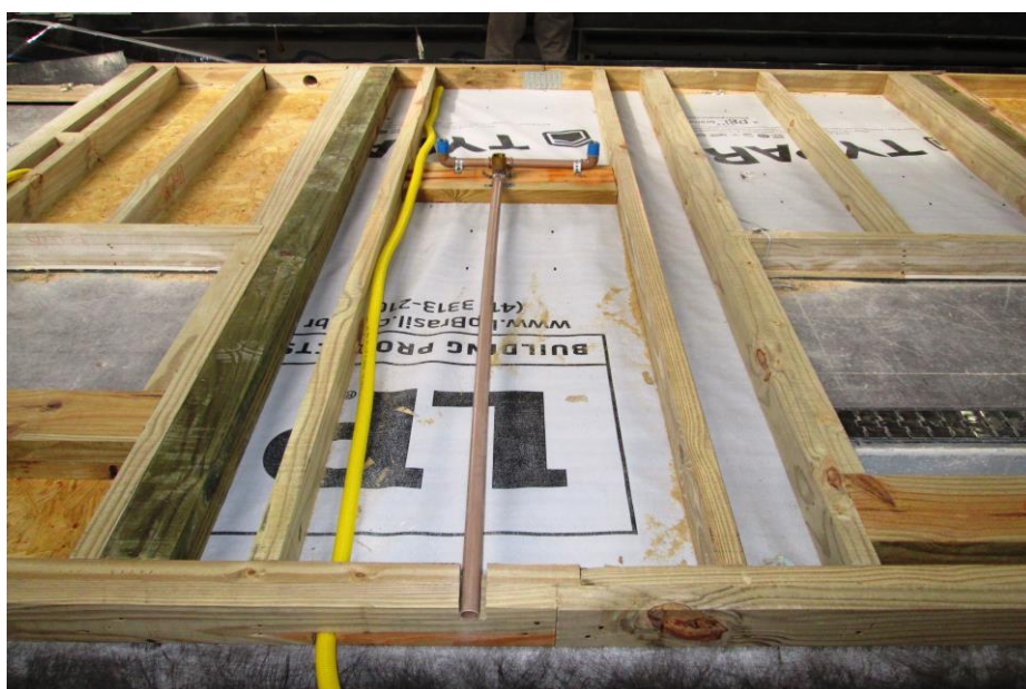
FIGURA 05: PAINEL PARA SER INSERIDO SISTEMA ELÉTRICO E HIDRÁULICO
