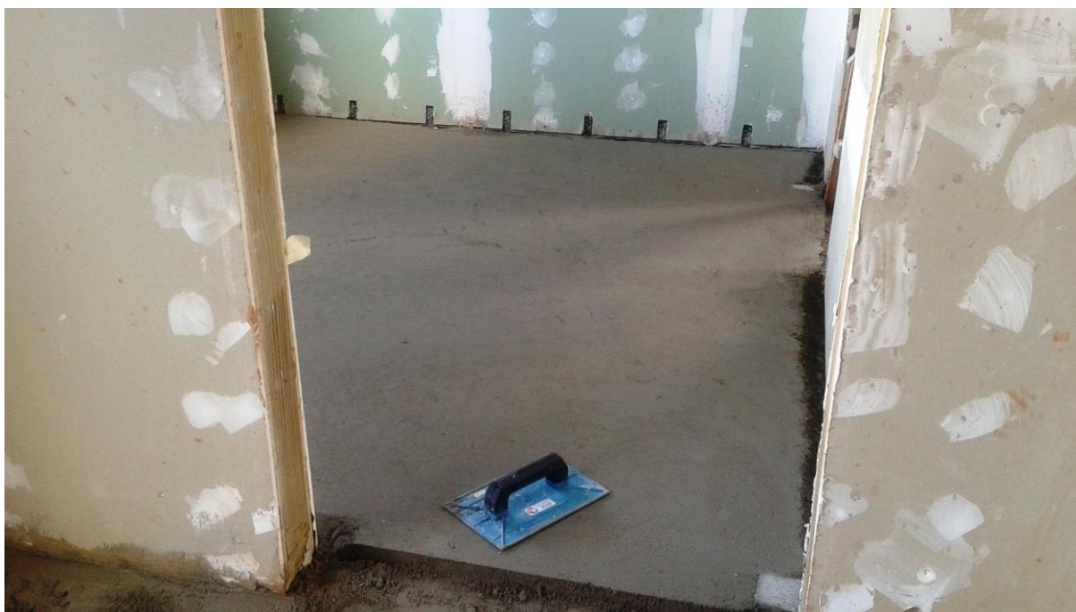
FIGURA 02: EXECUÇÃO DE CONTRA PISO.
