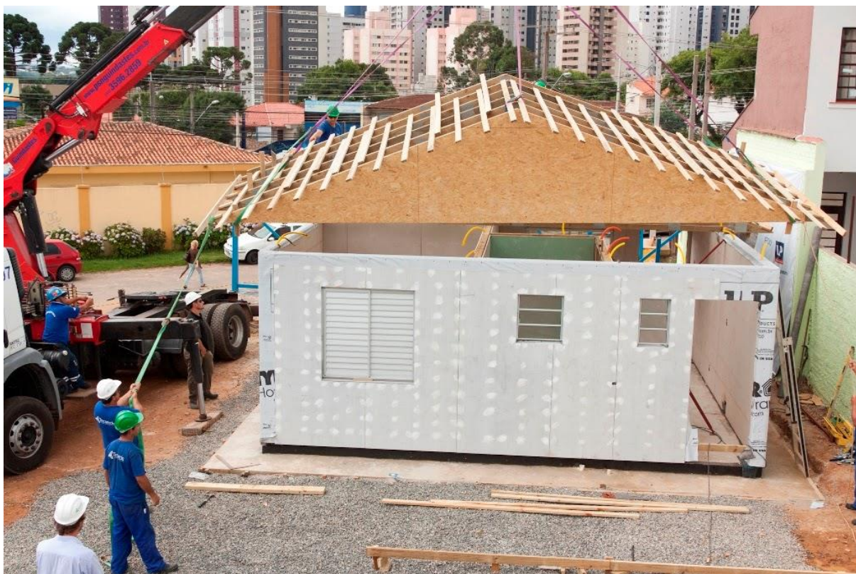
FIGURA 08: TELHADO PRÉ FABRICADO.
