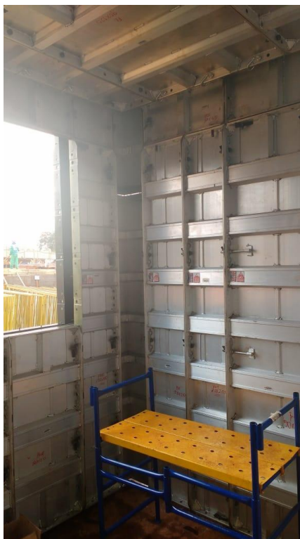
Figura 2.2 - Fôrma de Alumínio de Paredes.
