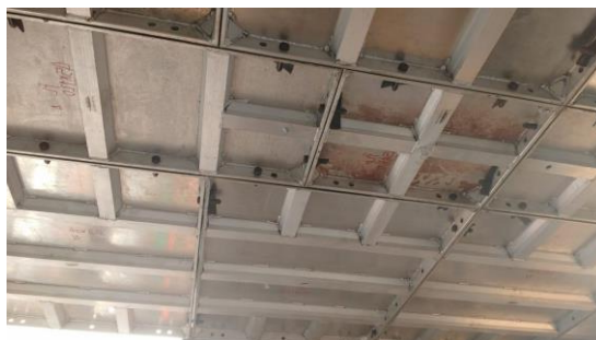
Figura 2.1 - Fôrma de Alumínio de Laje.
