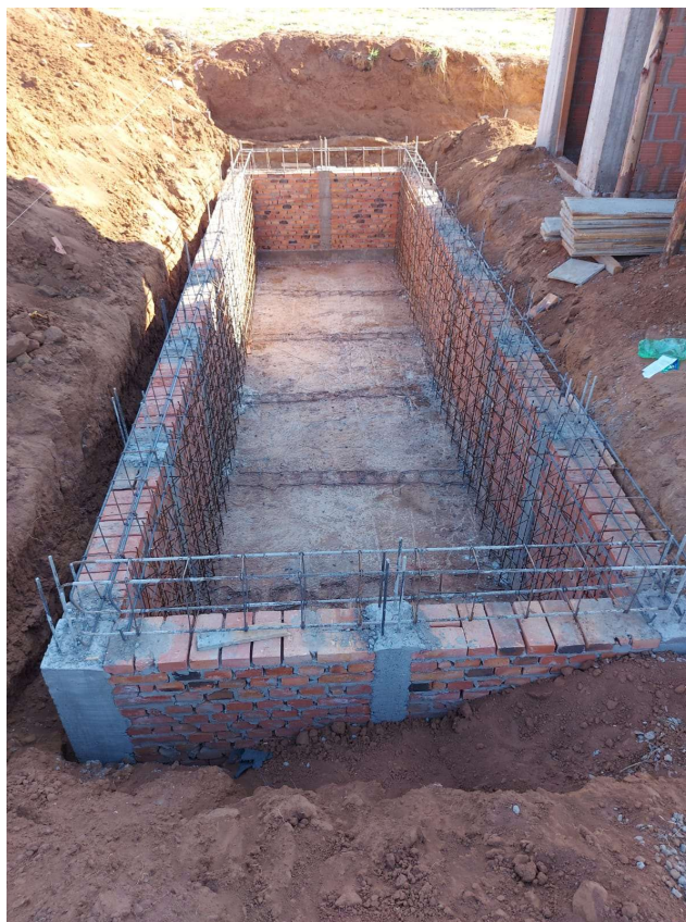
Figura 13 – Execução da piscina
