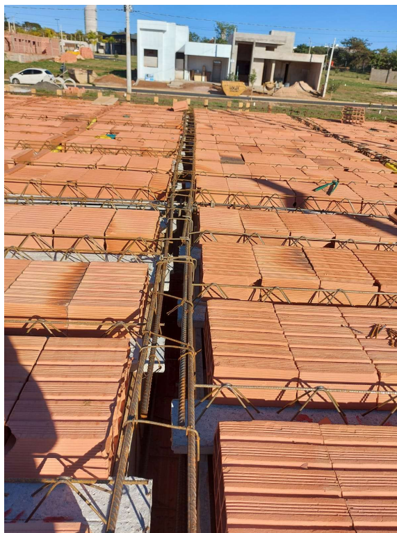
Figura 12 – Montagem da laje
