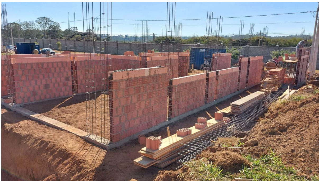
Figura 09 – Execução da alvenaria pavimento térreo
