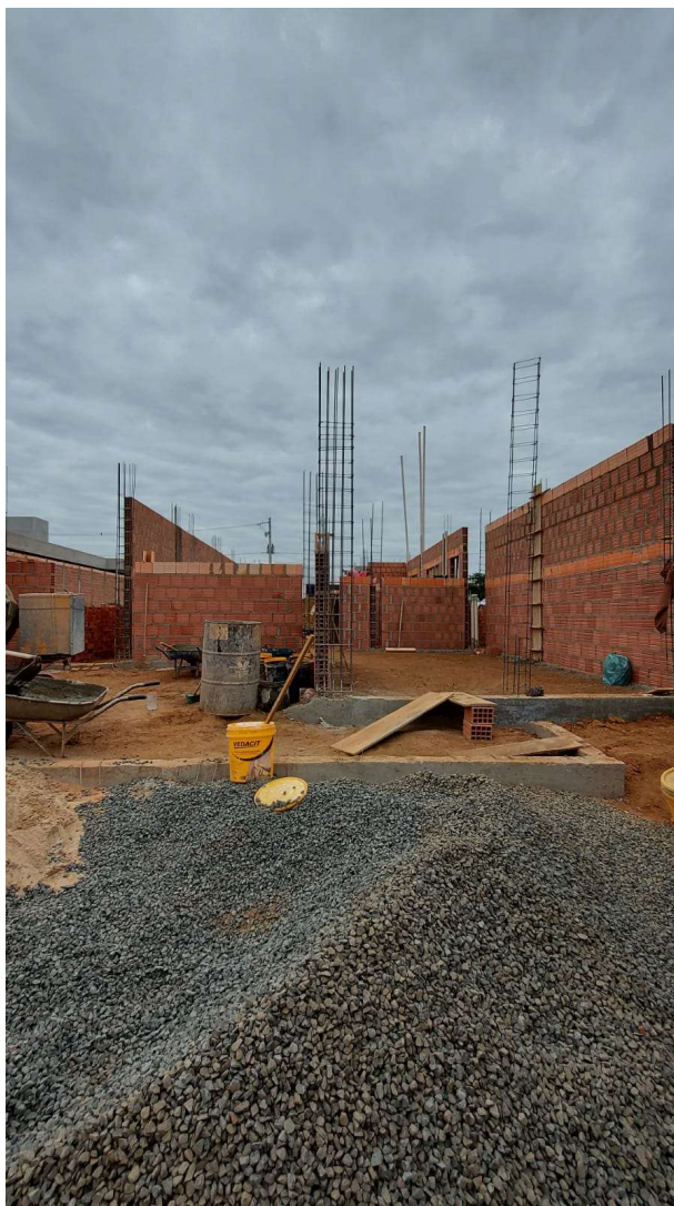
Figura 10 – Armazenamento dos materiais
