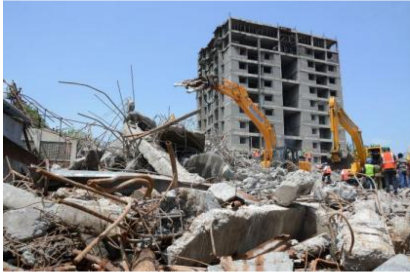
FIGURA 01: RESÍDUOS DA CONSTRUÇÃO CIVIL APÓS DEMOLIÇÃO
