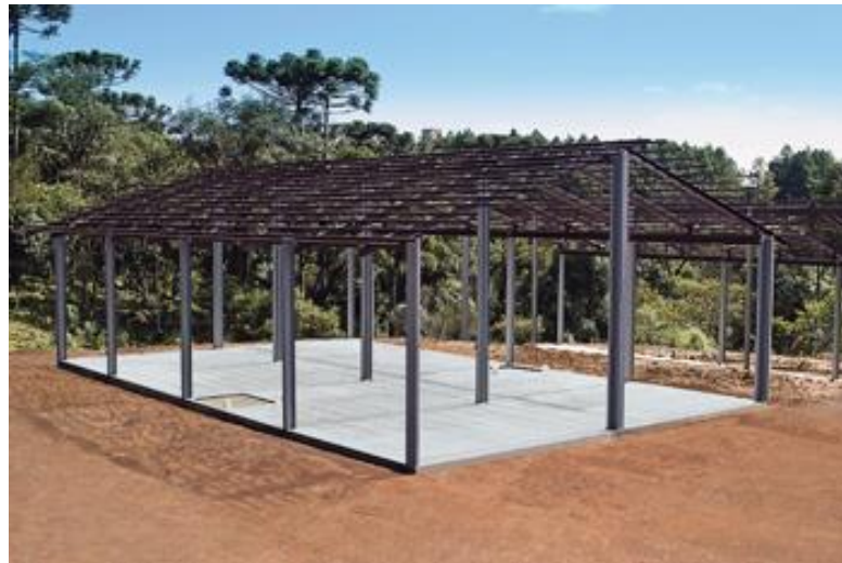
FIGURA 9: INÍCIO DA CONSTRUÇÃO
