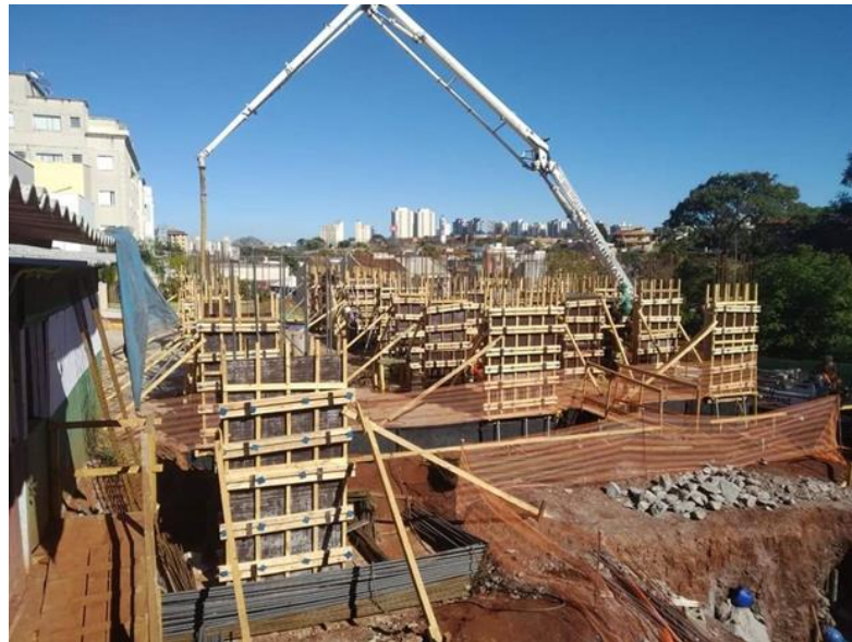
FIGURA 05: CONSTRUÇÃO INFINITY TOWER
