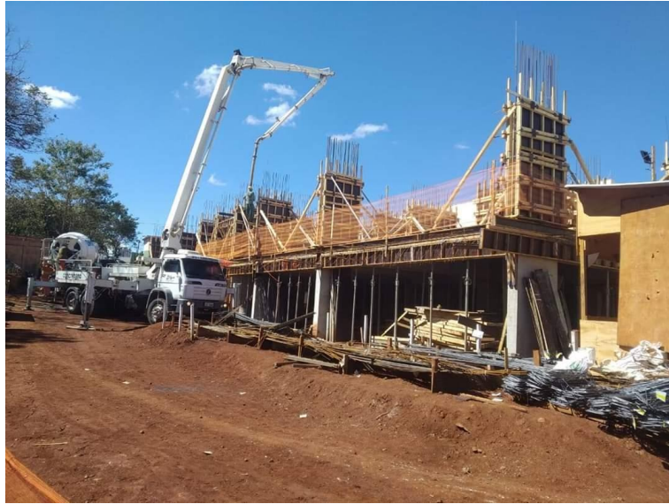
FIGURA 06: CONSTRUÇÃO INFINITY TOWER
