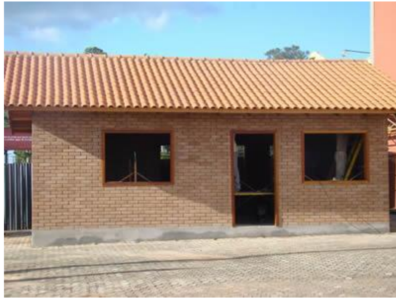
FIGURA 10: FINALIZAÇÃO DA CONSTRUÇÃO
