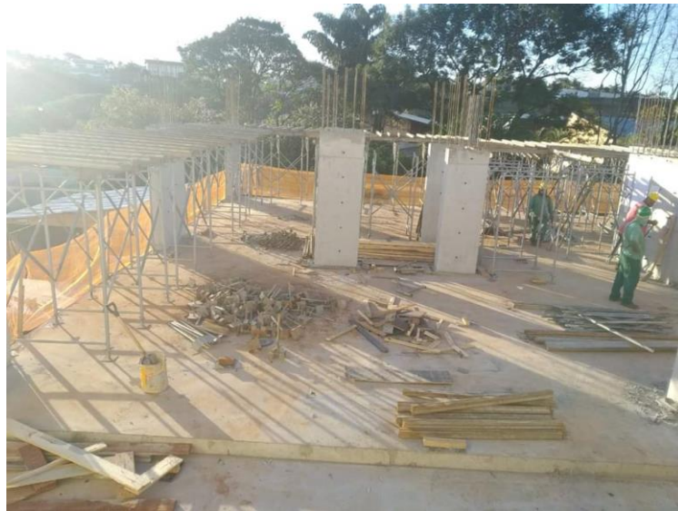
FIGURA 07: CONSTRUÇÃO INFINITY TOWER
