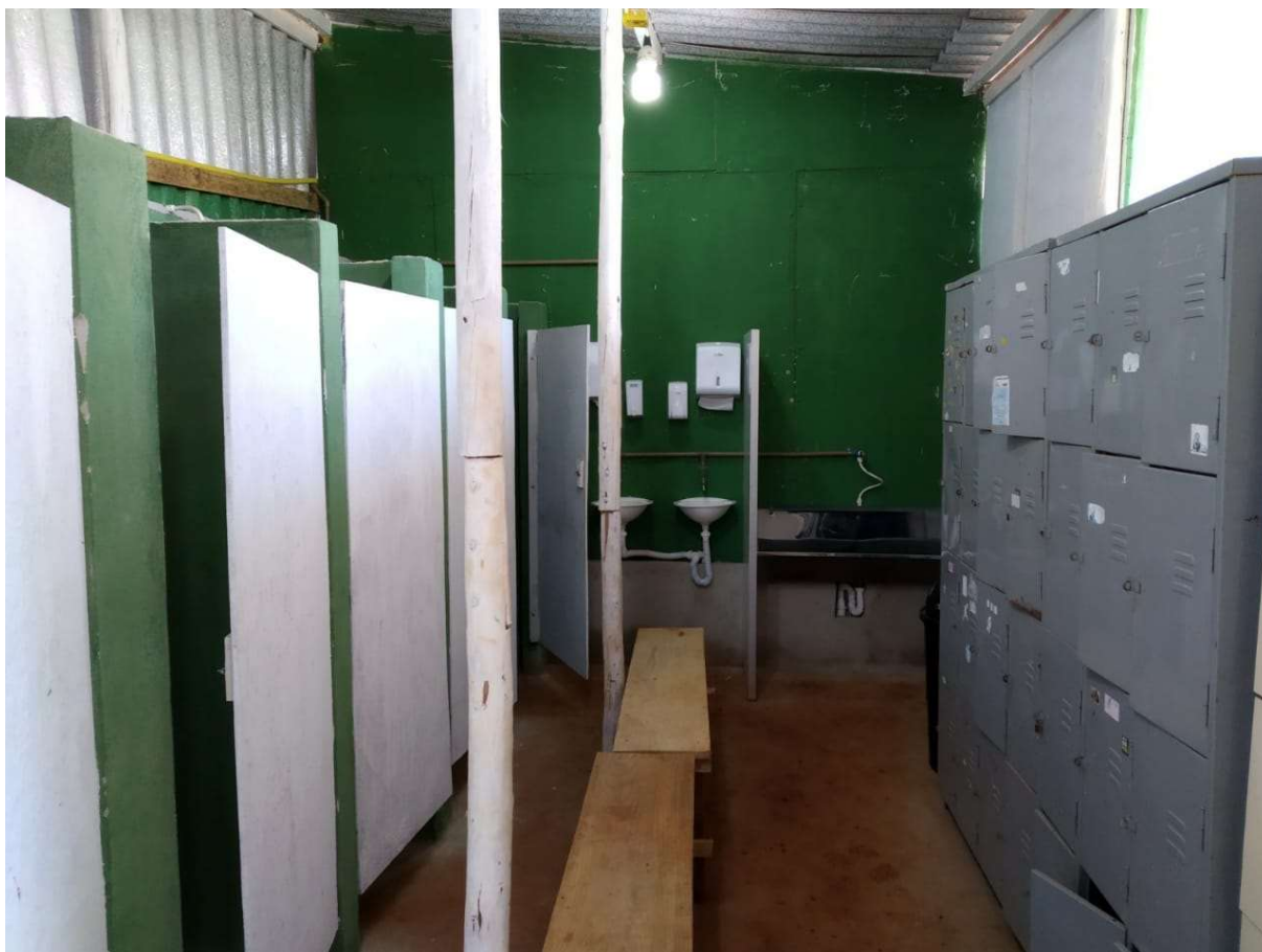
Figura 4 –Vista 1 do banheiro
