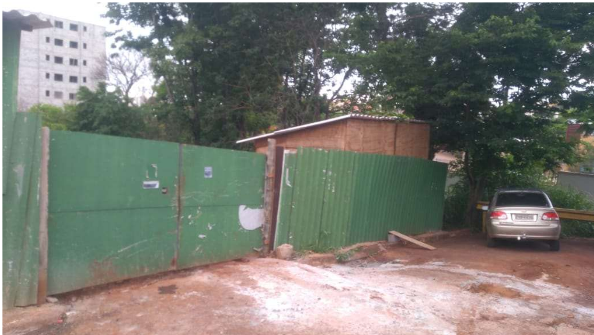
Figura 27 –Vista 1 externa da obra
