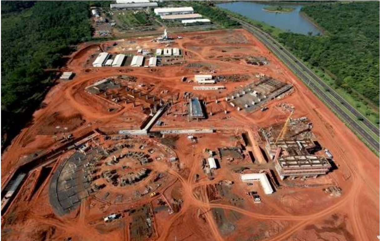
Figura 2 - Construção de planta industrial
