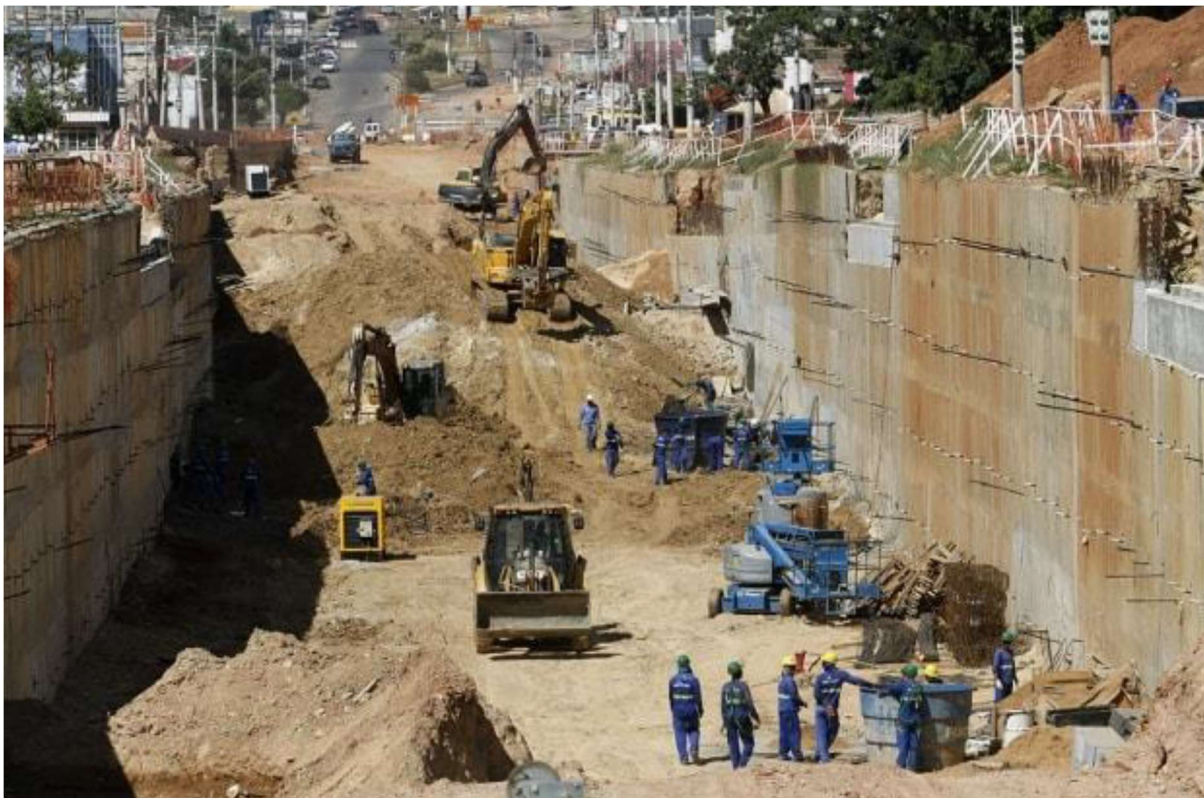
Figura 3 - Construção de obras viárias
