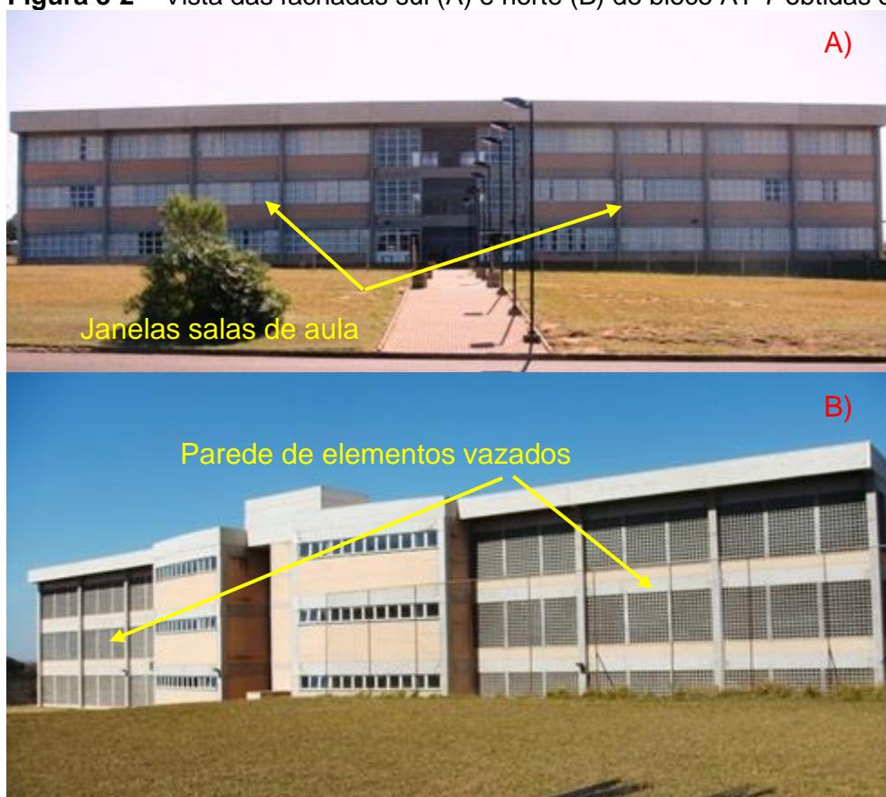
Figura 3-2 – Vista das fachadas sul (A) e norte (B) do bloco AT-7 obtidas em 2011.
