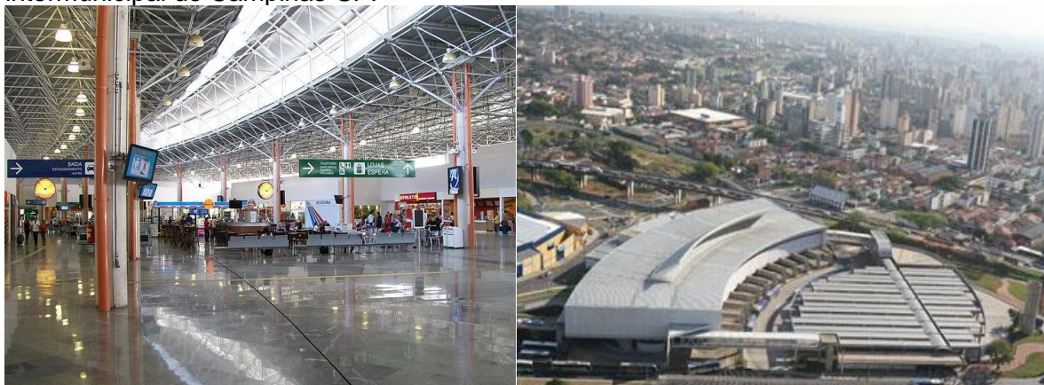
Figura 2-9 - Vista do interior (à esquerda) e superior (à direita) da estação rodoviária intermunicipal de Campinas-SP.
