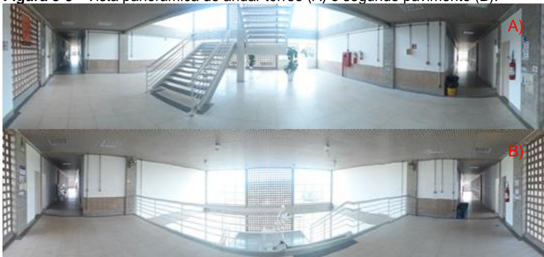
Figura 3-3 - Vista panorâmica do andar térreo (A) e segundo pavimento (B).
