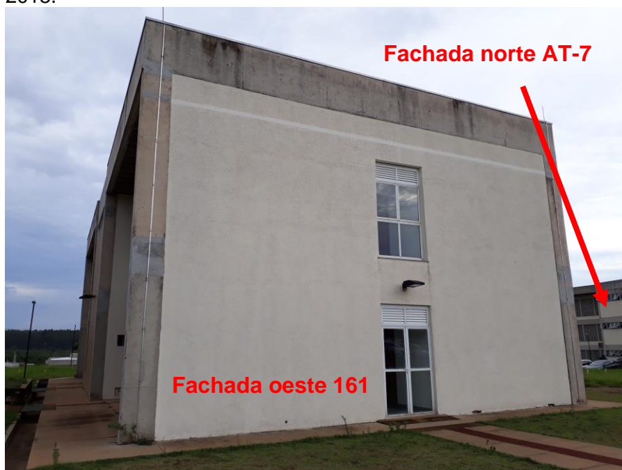
Figura 3-15 - Vista da fachada oeste do edifício 161 e da fachada norte do AT-7 obtidas em 2018.
