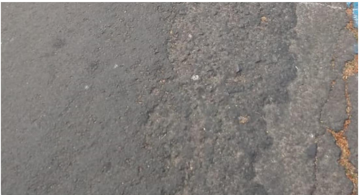
Figura 34 – Desgaste
