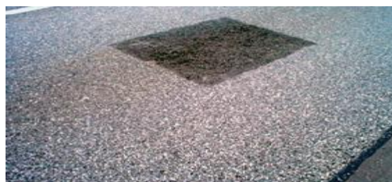
Figura 24 – Remendo bem executado
