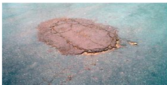
Figura 24 – Remendo bem executado
