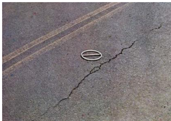
Figura 13 - Trinca longitudinal
