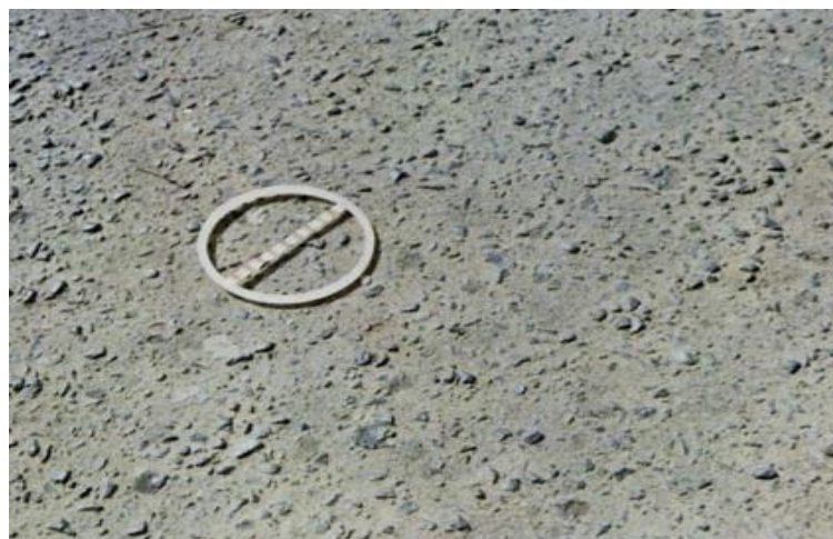
Figura 21 - Desgaste
