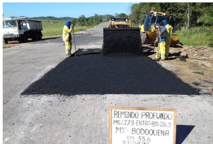
Figura 26 - Remendo Profundo
