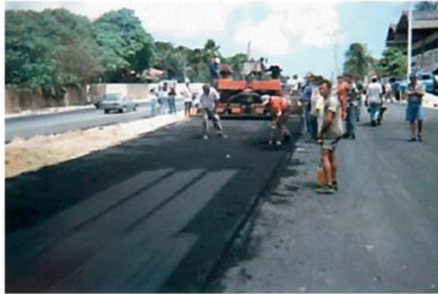
(b) Revestimento asfáltico sendo executado
