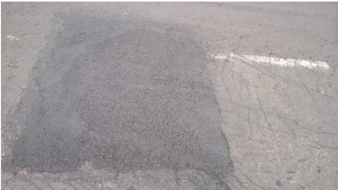
Figura 39 - Remendo
