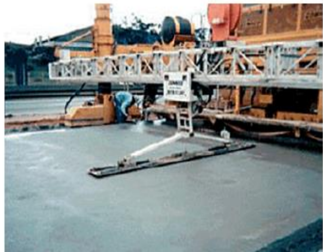
(b) Revestimento em concreto de cimento Portland sendo executado
