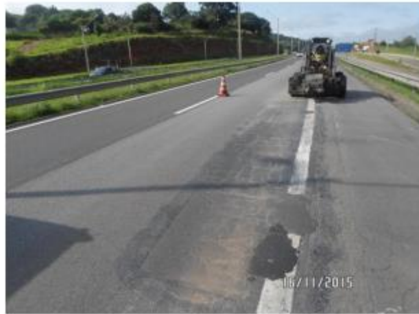
Figura 27 - Remendo Superficial
