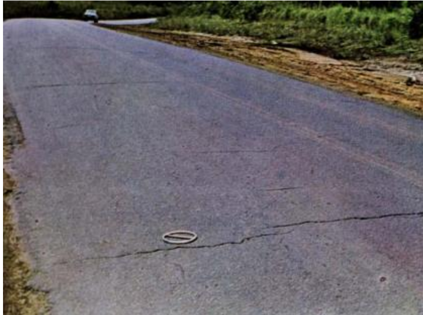
Figura 12 - Trinca transversal
