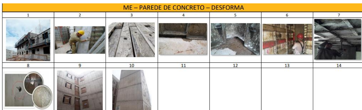
Figura 13: Execução do serviço
