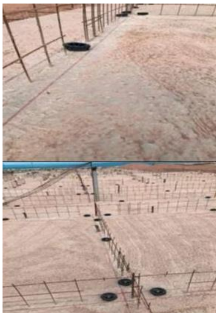
Figura 16: Marcação das paredes
