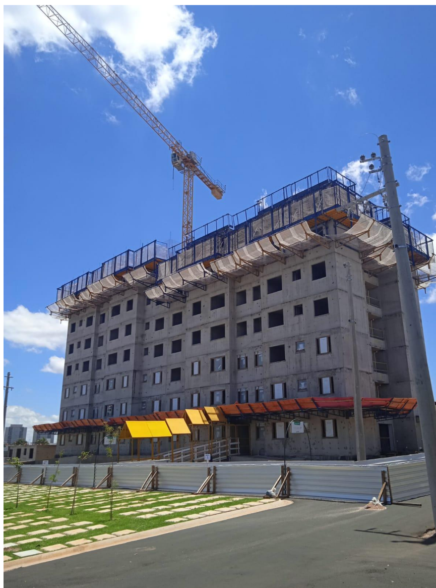
Figura 14: Parede de concreto
