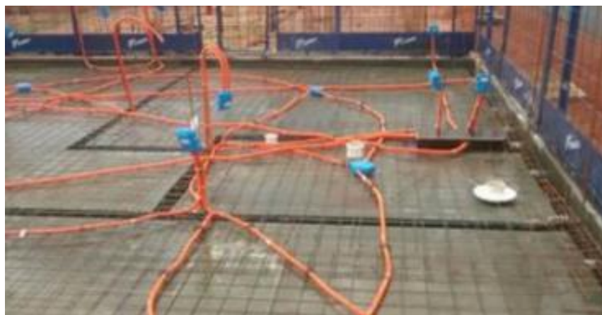
Figura 6: Circuito de tomadas executadas pelo chão
