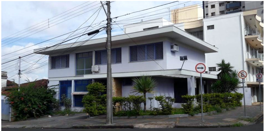
Figura 4: Residência Jesus Silva, antes da reforma de 2020. (2019)
