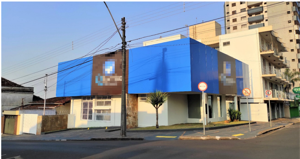
Figura 7: Residência Jesus Silva após reforma finalizada em outubro de 2020. (2020)
