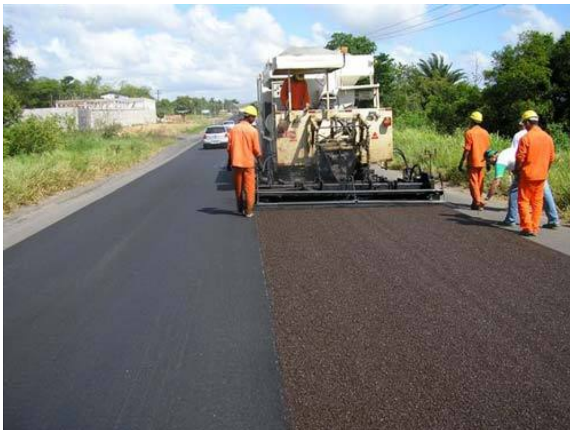
Figura 6 Tratamento superficial simples por penetração invertida
