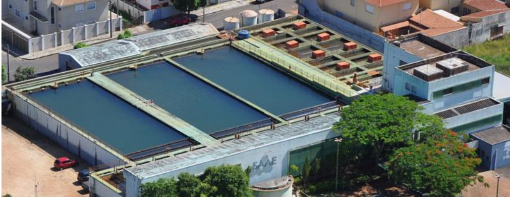
Figura 7. Estação de Tratamento de Água de São Carlos.
