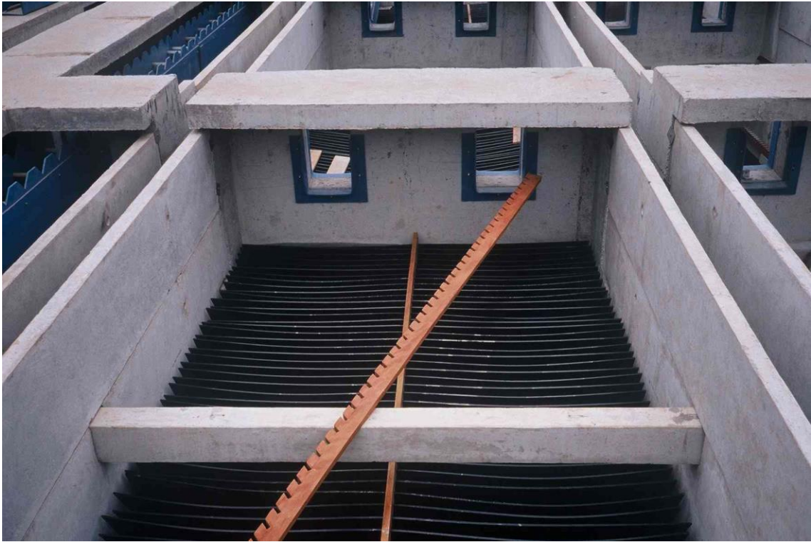
Figura 4. Decantador de Alta Taxa em construção.
