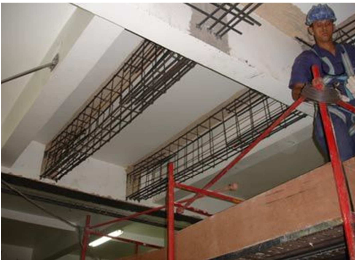
Figura 3.1 - Reforço com vigas de Concreto.
