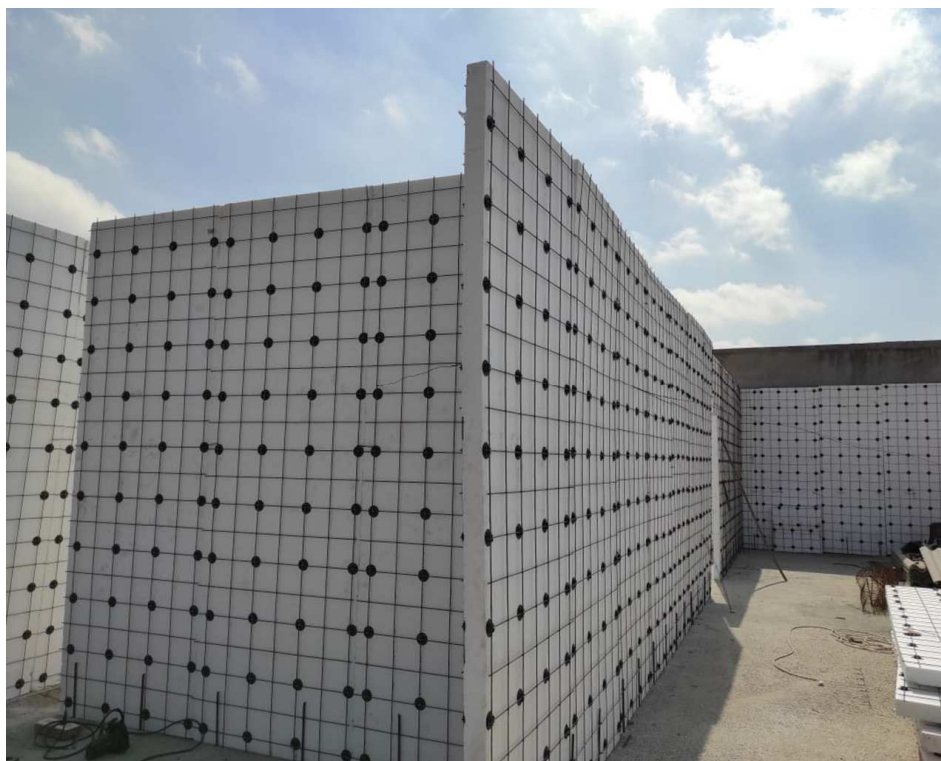
Figura 6 – Construção com painéis monolíticos em EPS
