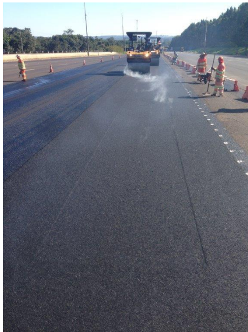
Figura 12. Compactação do revestimento
