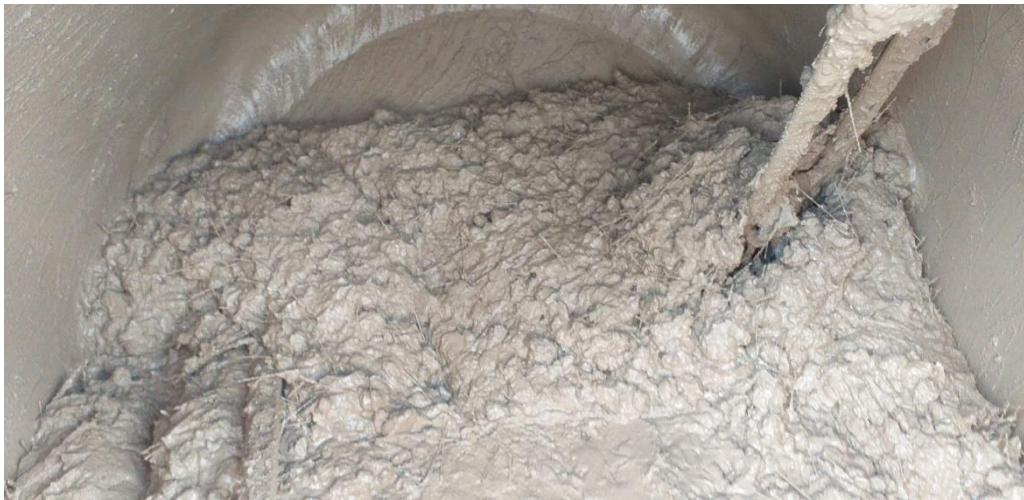
Figura 4: Concreto misturado, pronto para a moldagem.
