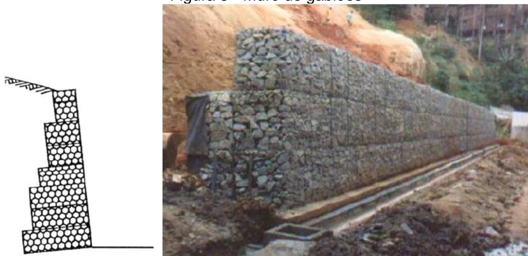
Figura 5 - Muro de gabiões
